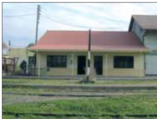
Estación Faustino Parera, antes (arriba) y después de ser recuperada. Hoy funciona como Oficina de Turismo, Museo ferroviario, biblioteca y sala de internet.
